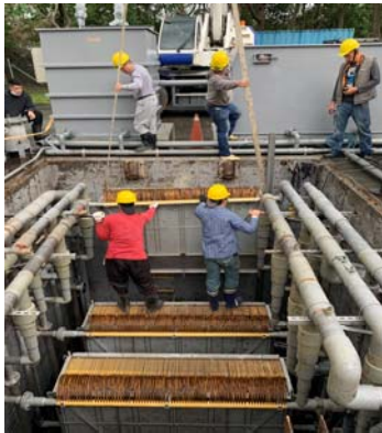
↑ 指導拆卸與吊出膜組
