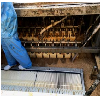
以本公司 12 套平板膜組替換日本 24 套中空絲膜組
