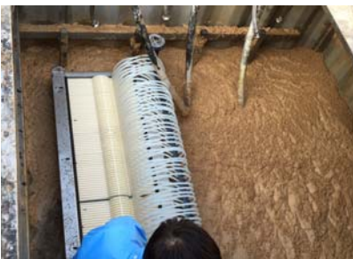
以本公司 12 套平板膜組替換日本 24 套中空絲膜組
