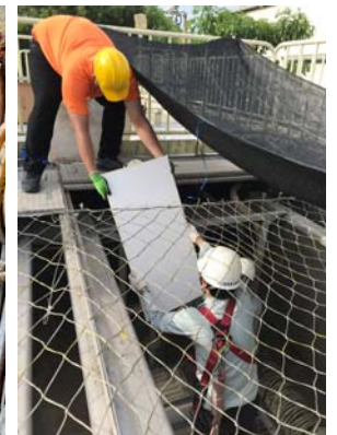
↑ 台灣康牌膜板沾黏污泥相互擠壓報廢, 以本公司膜板替換: 國瑞車廠
